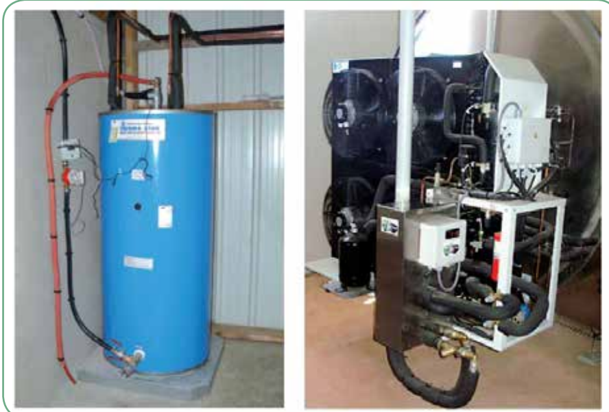
Un récupérateur de chaleur interne (à gauche) et de chaleur à plaques (à droite).
